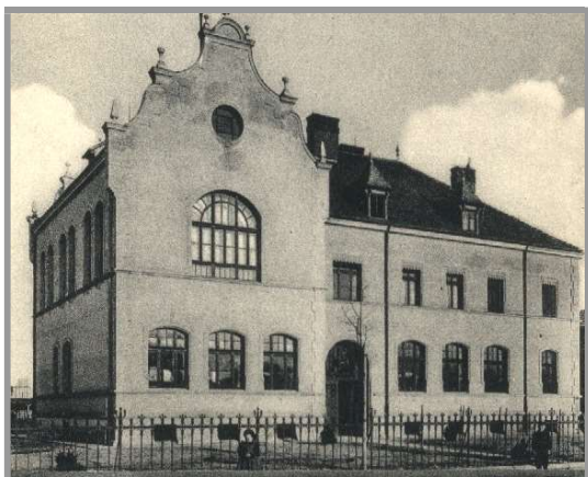
Obecnie tzw. budynek nr 2 szkoły (dawny internat) - przed przebudową
