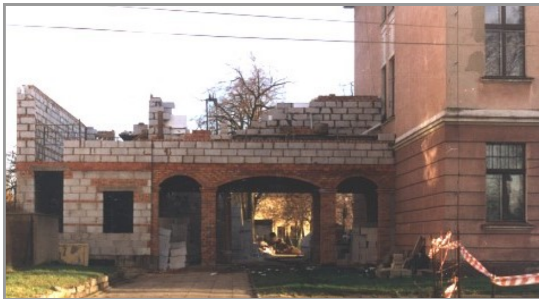
Listopad 1996 roku – budowa węzła sanitarnego
