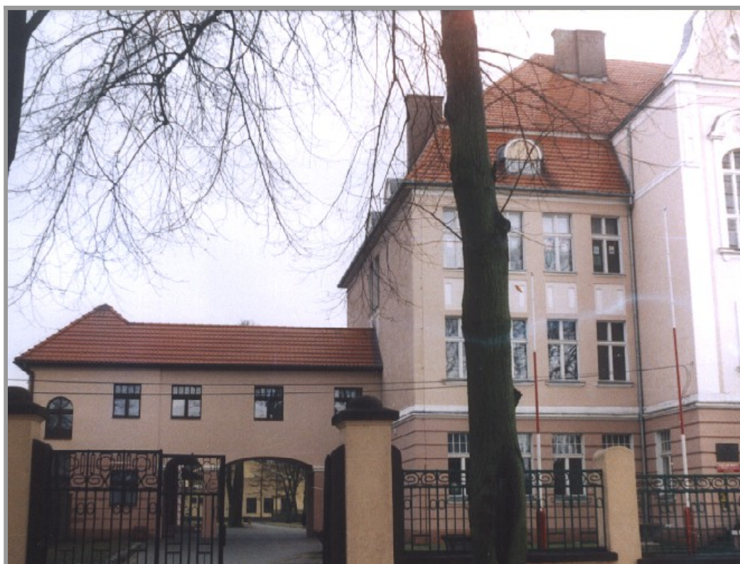
Po lewej – fragment dobudowanej części węzła sanitarnego
