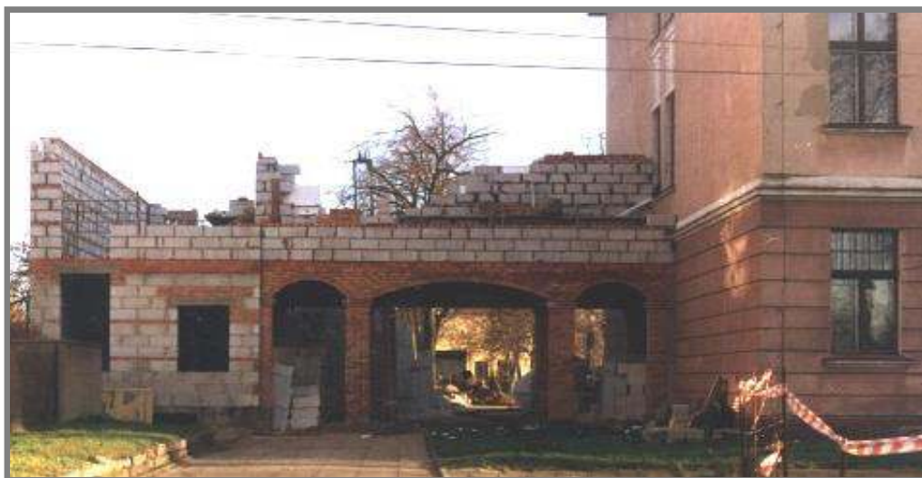
Listopad 1996 roku – budowa węzła sanitarnego
